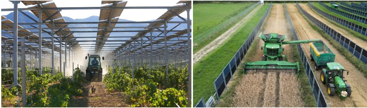
სურათი 8: აგროელექტრული სისტემები ვენახში (მარცხნივ, წყარო: SunAgri), ვერტიკალური აგროელექტრული სისტემები (მარჯვნივ, წყარო: Solar Builder Magazine)
